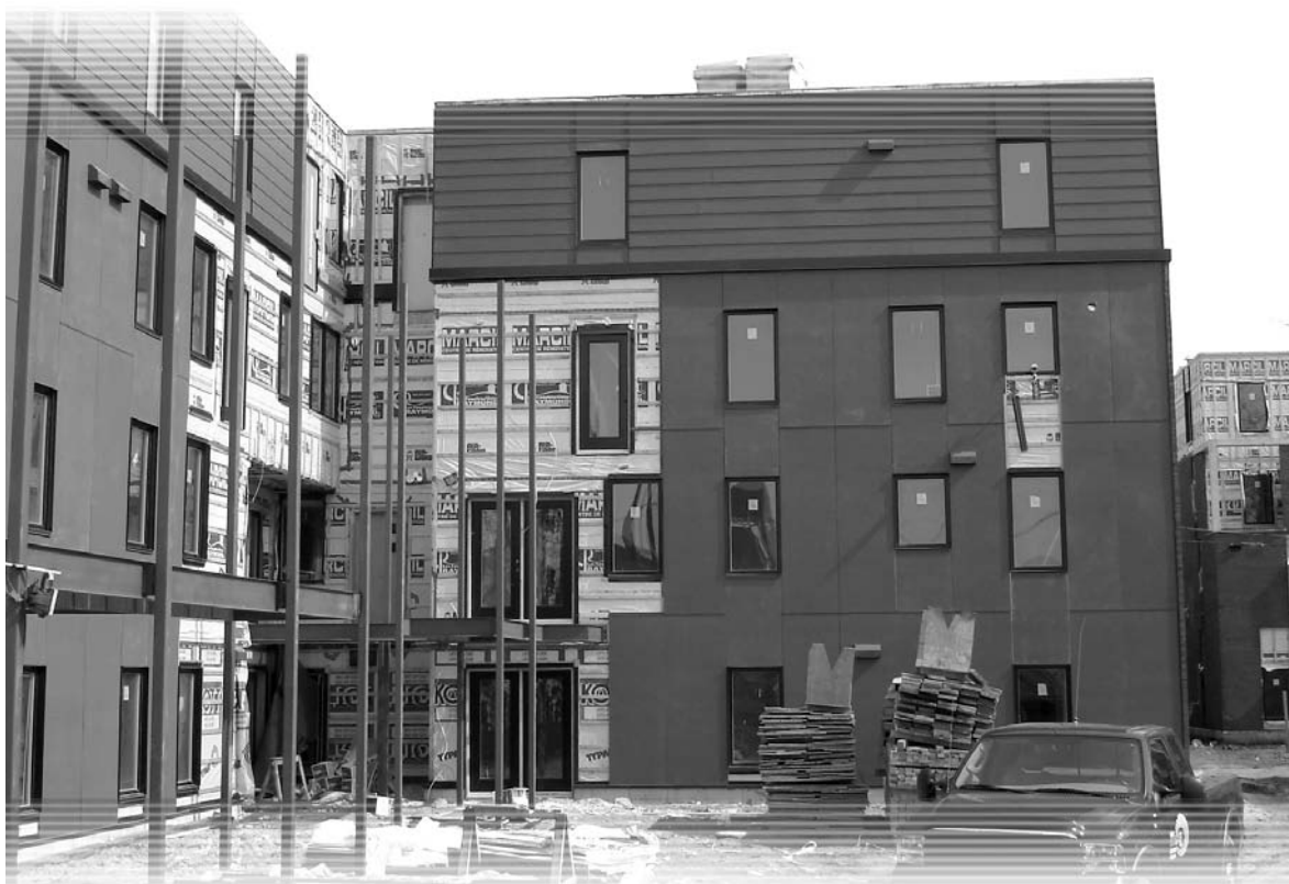
Tout au long du chantier, nous avons suivi de près la construction des plex qui accueillent maintenant 52 familles.
